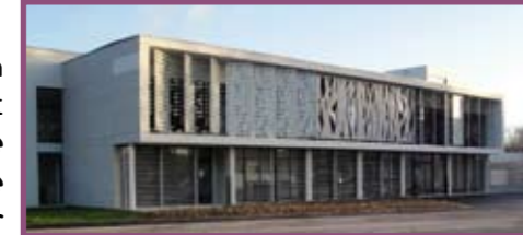
Le collège de Colombey-les-Belles, reconstruit à neuf en 2011 : un prélude au plan Collèges Nouvelles Générations
